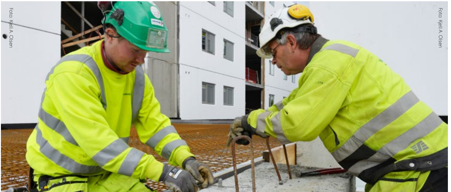
Kim Erik Hansen (t.v.) og Rolf Olsen i arbeid for Teknobygg Anlegg.
