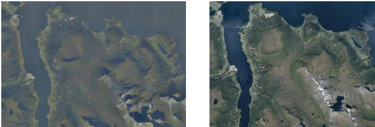
Figur 4-12: Flyfoto over E136 Tresfjordbrua-Vågstrandstunnelen. Kilde: Norkart gjennom 1881s karttjeneste.
