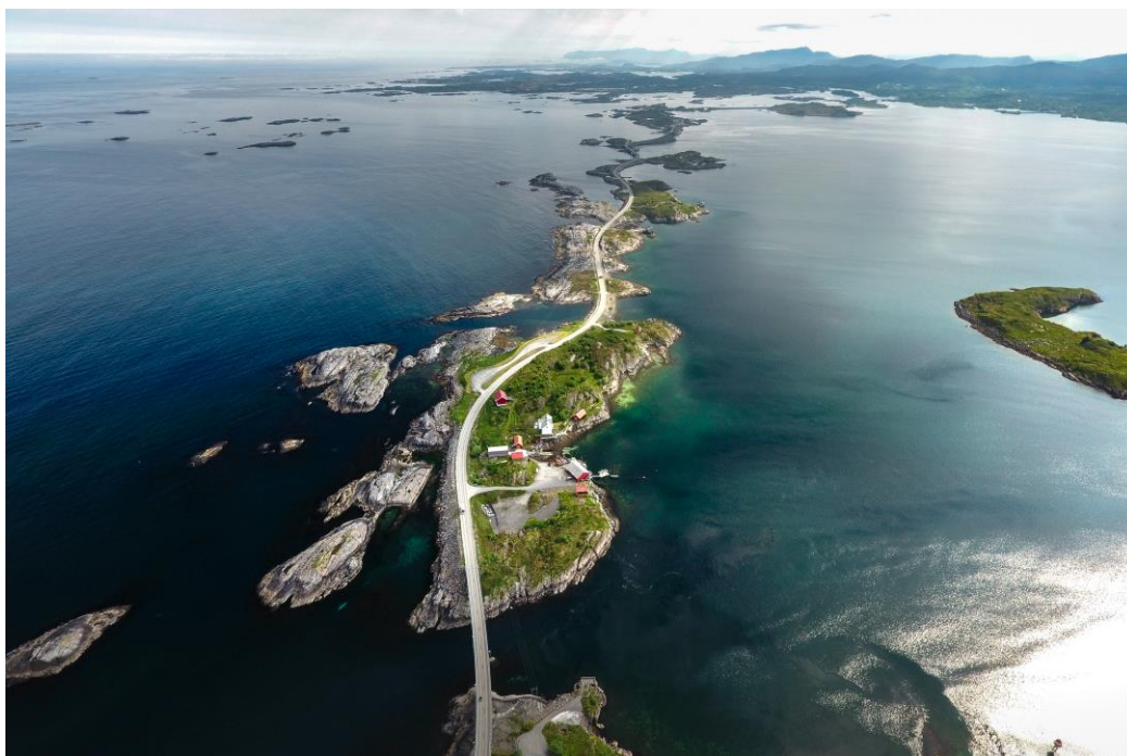
Figur 9: Atlanterhavsvegen er en unik veistrekning som forbinder Averøy med fastlandet over øyer, holmer og skjær ved hjelp av 7 bruer over en strekning på 8274 meter. © Foto: Kjetil Rolseth
